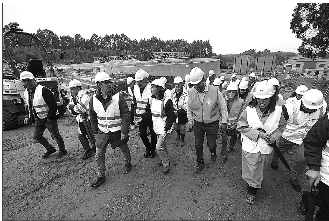
La conselleira Ángeles Vázquez visita la Estación Depuradora de Aguas Residuales (EDAR) en Foz.
