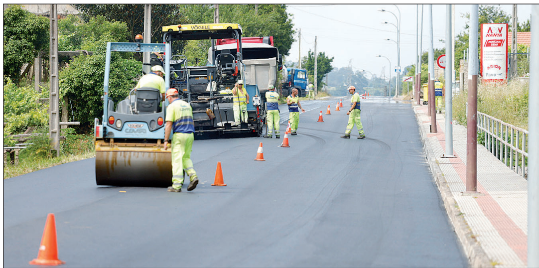
Refuerzo del firme en la carretera PO-550 en la localidad de Meaño.
