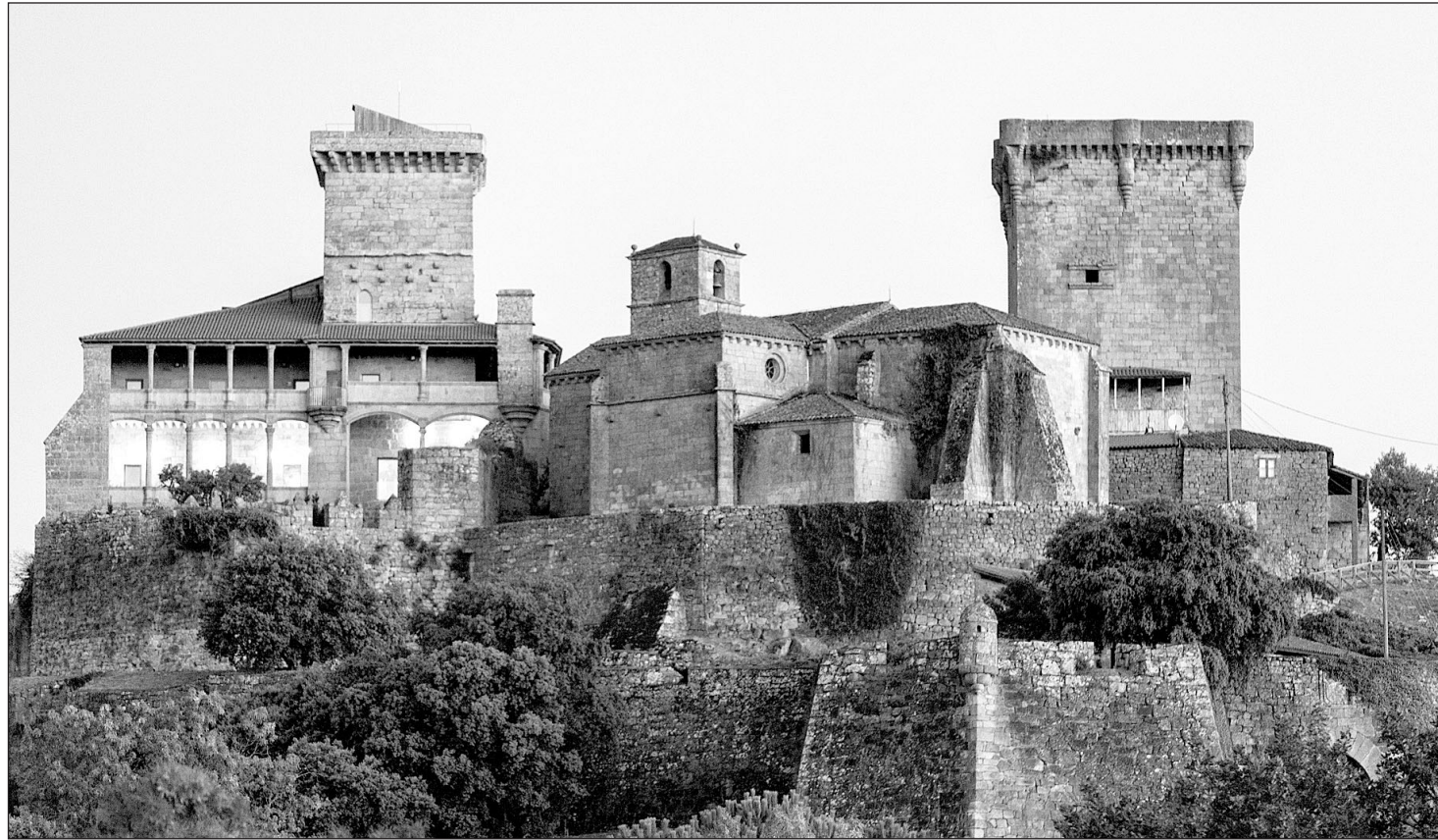
El Castillo de Monterrei, en Verín (Ourense), sobresale entre los que reciben mayor dotación de los fondos Next Generation para el turismo en Galicia.
