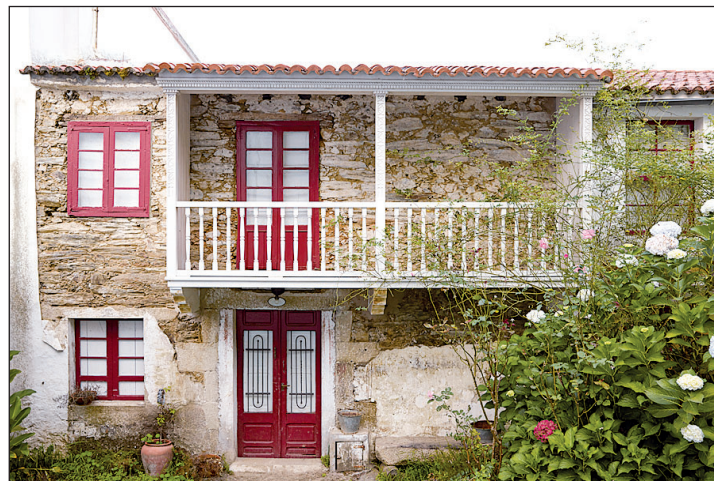
Corredor de una casa de Paderne, restaurado con las ayudas.
