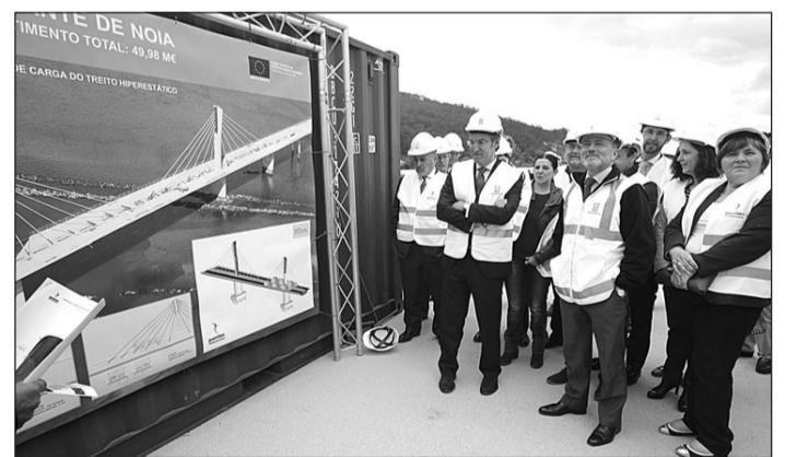
Feijóo y Agustín Hernández, durante la visita a las obras de la variante.
