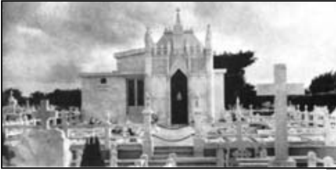
Magnífica vista general del panteón, donde se observa toda su estructura terminada (1957). Obsérvese las estatuillas de San Emeterio y San Celedonio a la entrada, que recién desaparecieron misteriosamente.
