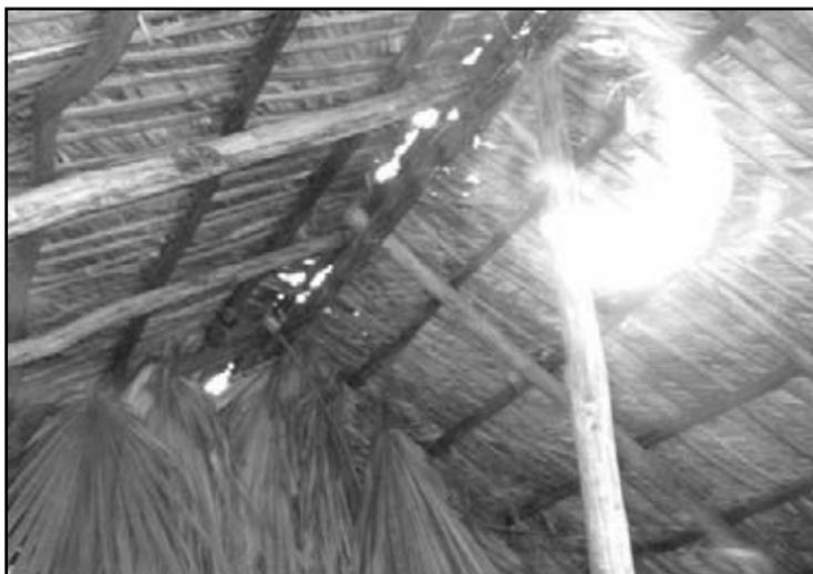
*Vista general interior de la cubierta de un rancho, donde se señala la forma primitiva de soportar la cobija, de guano, soporte basado en cujes y vigas de maderas con puntillas para agarrar el guano al cuje.*
